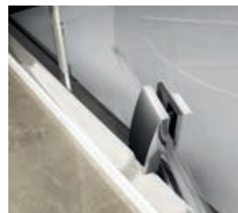
Nezničiteľný pivotový mechanizmus otvárania dverí
