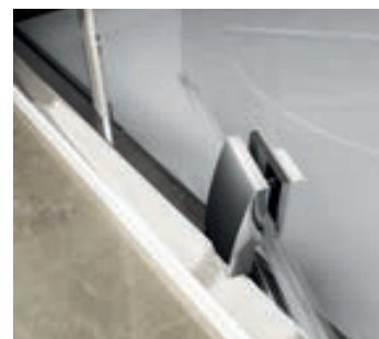
Nezničitelný pivotový mechanizmus otvárania dverí
