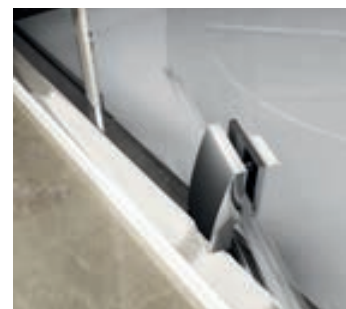
Nezničiteľný pivotový mechanizmus otvárania dverí
